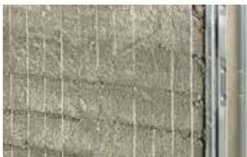
El Mortero se aplica fácilmente, porque está sujeto por una red corrugada de malla espesa (25 x 50 mm), situada justo a la mitad entre la chapa y el enlucido.
